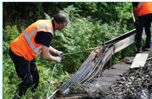
Mitarbeiter der DB reparieren durch einen Brandanschlag beschädigten Kabeltunnel (dpa)
