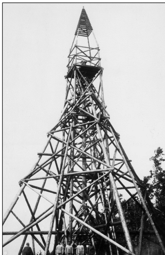
Abb. 20: Trig. Signalturm auf der Ziegenhelle 1893 (PrLA-Vermessungsakten, Bundesamt für Kartographie und Geodäsie, 2011)
